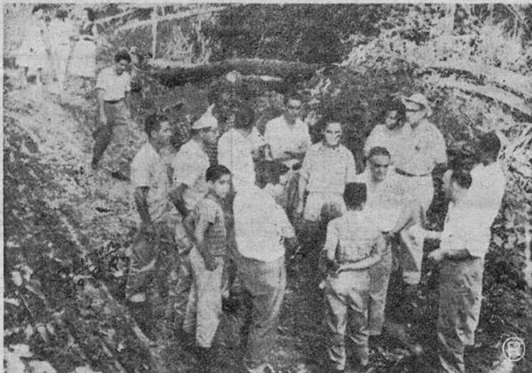
Un grupo de diputados, entre ellos Cordero Croceri y Vargas Ramírez visitaron diversas localidades de la zona atlántica la semana anterior. Aquí los vemos mientras recorrian la trocha de la carretera Limón San José.
